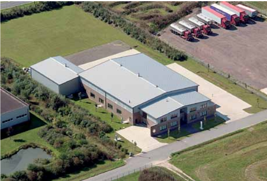
Bild 2: Luftbild der Lars SAFFE Zerspanungstechnik GmbH, Martfeld. Keine Oberlichten im Dach, kleine Fensterflächen
