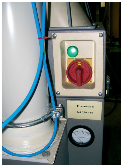
Bild 3: Ein stromloses Differenzdruckmanometer zeigt den Zustand des Partikelfilters an
