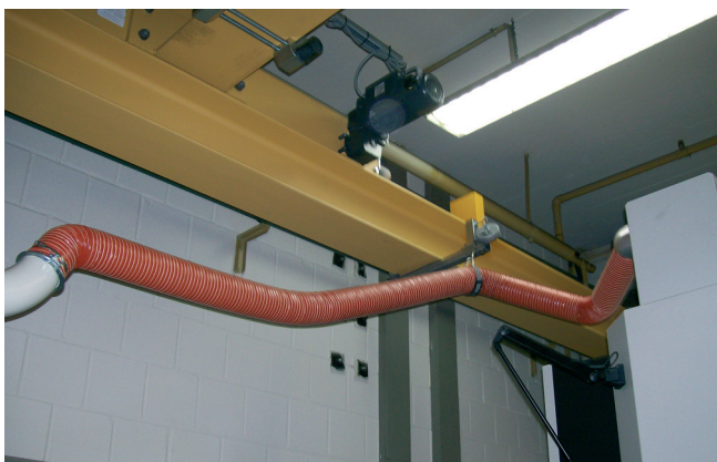
Bild 1: Ein Balancer verhindert das Durchsacken des Schlauches
